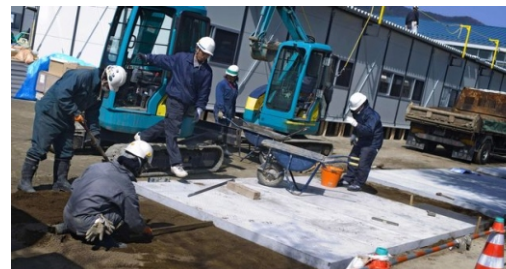
Figura 32 - Montagem Alojamentos temporários desabrigados terremoto Japão. Fonte: www.extra.globo.com/noticias/mundo . Abril, 2011.
